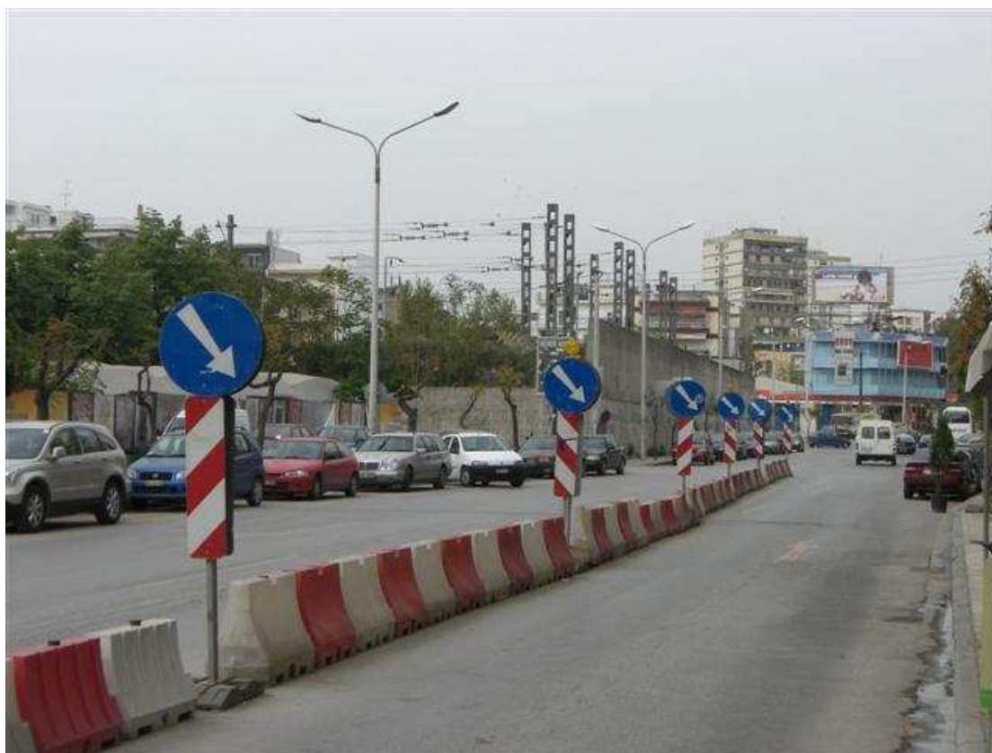
Εικόνα 9: Διαχωρισμός κυκλοφορίας με ομοιώματα στηθαίου ΝJ στο σταθμό ΝΣΣ
