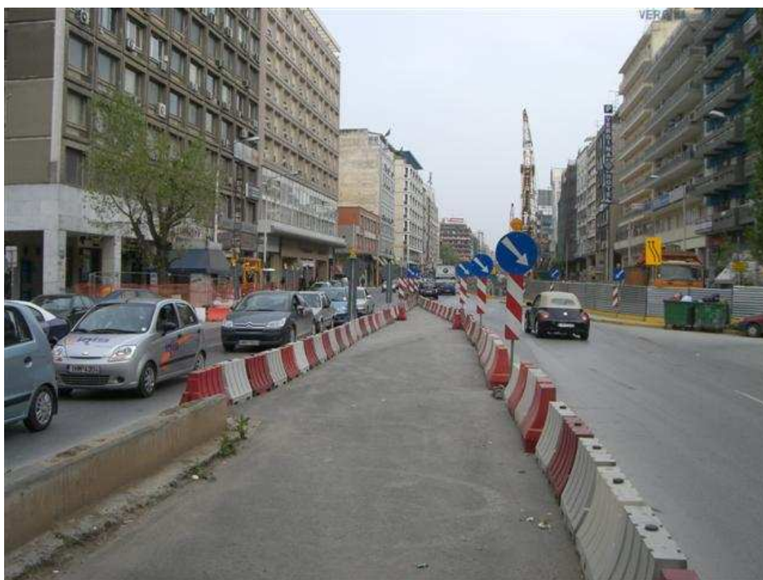
Εικόνα 8: Διαμόρφωση νησίδας με ομοιώματα στηθαίου NJ στο σταθμό ΝΣΣ
