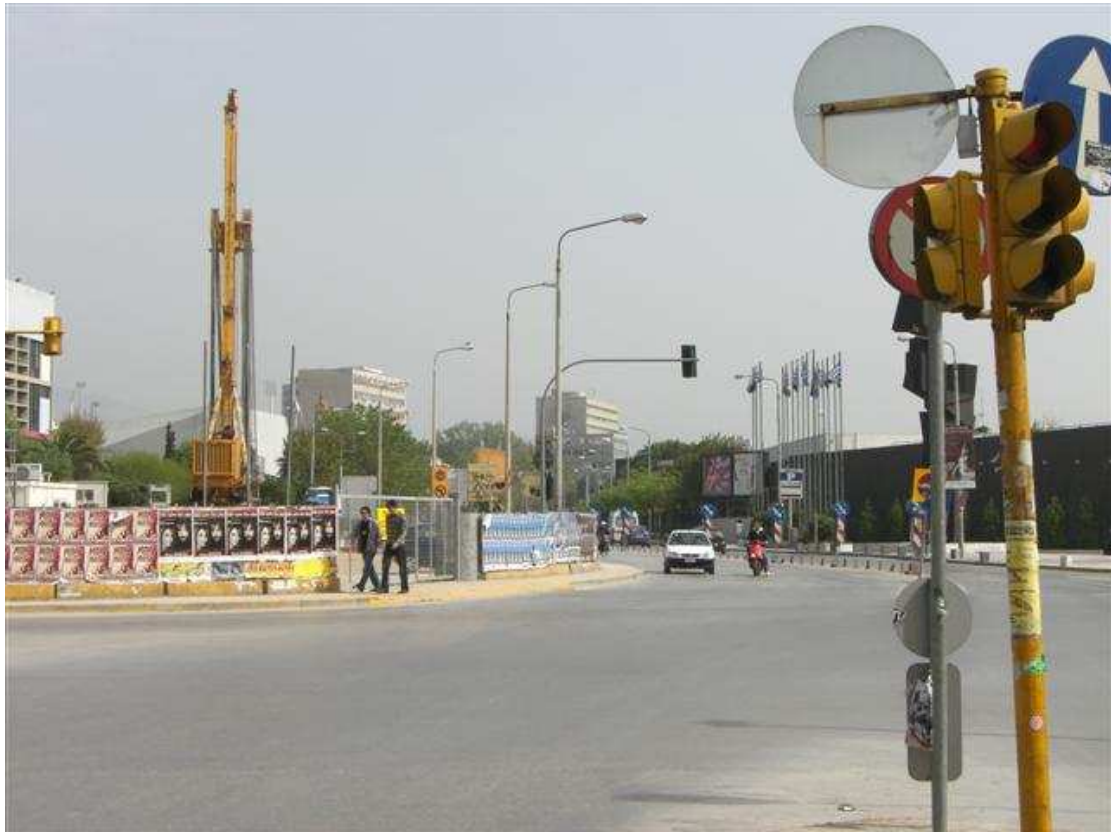
Εικόνα 21: Πεζοδρόμιο περιμετρικά του εργοταξίου στο σταθμό Συντριβάνι. Το πλάτος επαρκεί για την διέλευση δύο ατόμων
