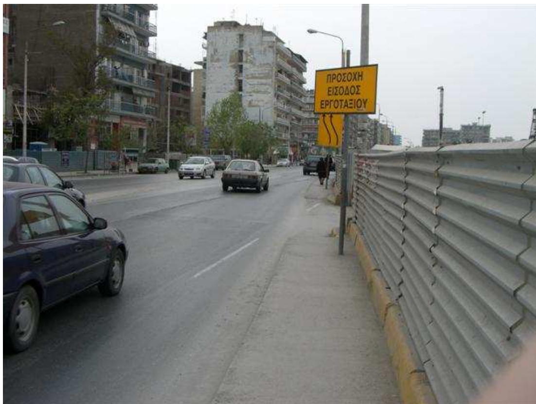
Εικόνα 20: Επισήμανση εισόδου – εξόδου εργοταξίου ΝΣΣ
