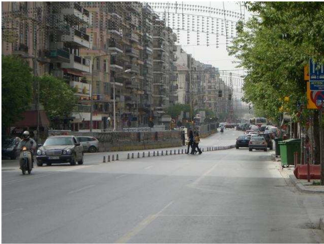
Εικόνα 4: Ελιγμός παράκαμψης εργοταξίου στο σταθμό Αγία Σοφία
