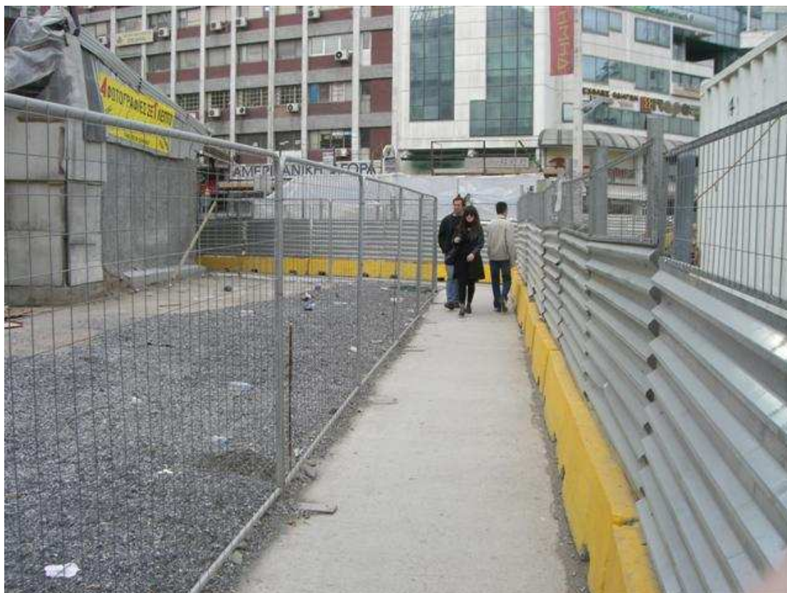
Εικόνα 33: Διάδρομος παράκαμψης εργοταξίου σταθμού Δημοκρατίας. Το πλάτος επαρκεί για δύο άτομα
