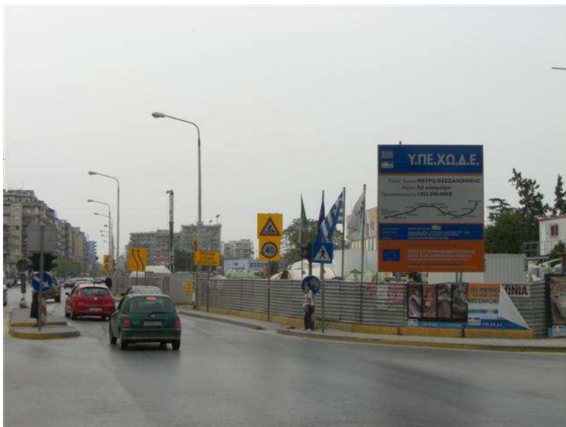
Εικόνα 36: Πεζοδρόμιο περιμετρικά του εργοταξίου στο σταθμό ΝΣΣ
