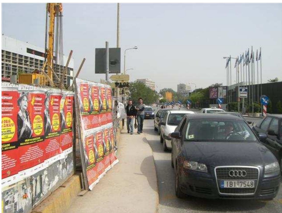
Εικόνα 26: Πεζοδρόμιο περιμετρικά του εργοταξίου στο σταθμό Συντριβάνι. Το πλάτος επαρκεί για την διέλευση δύο ατόμων
