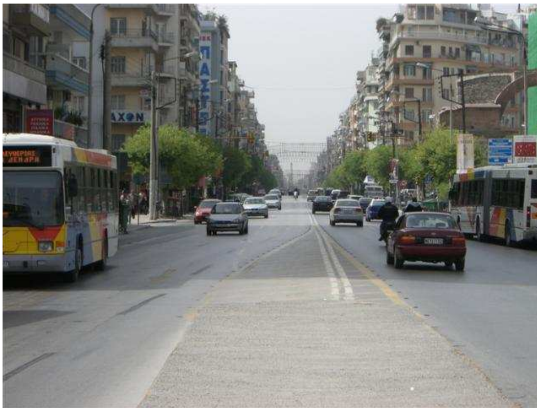
Εικόνα 1: Διαμόρφωση νησίδας με διαγράμμιση και μάτια γάτας στο σταθμό Συντριβάνι
