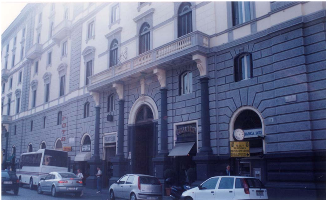
Πρόσοψη χωρίς σωληνώσεις
