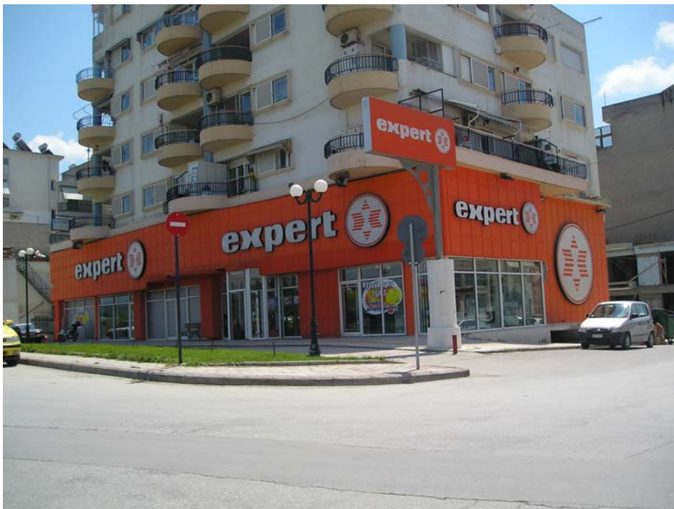
Φωτ. 46 Οδός Νιόβης
