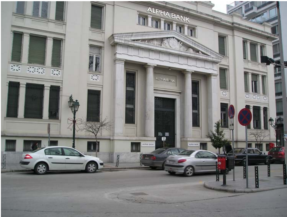
Φωτ. 61 Οδός Μητροπόλεως
