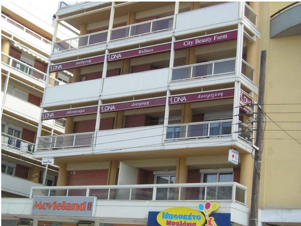
Φωτ. 11 Οδός Εθν.Αντιστάσεως
