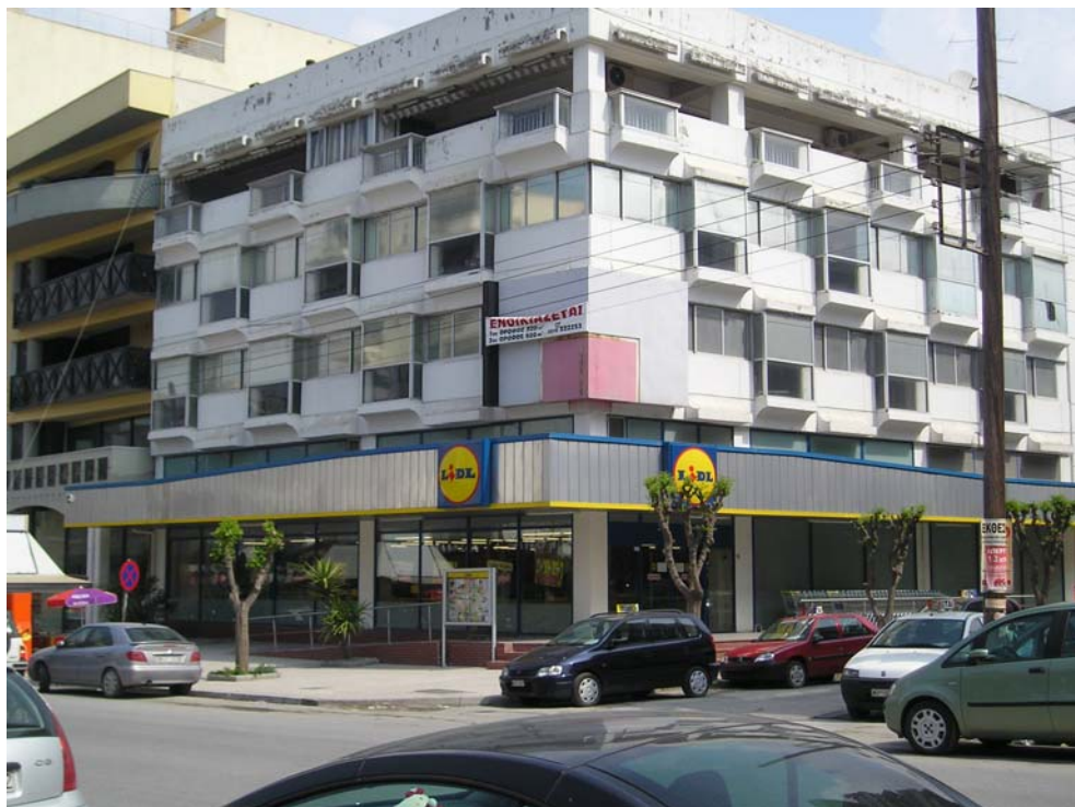
Φωτ.6 Οδός Εθν.Αντιστάσεως
