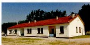
24 Στρατόπεδο «Ζιάκα», κτήριο διαμονής οπλιτών με ορθογώνιο περίγραμμα και έκκεντρες εσοχές.
