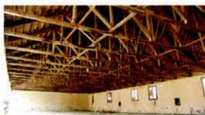
35 Στρατόπεδο «Καρατάσιου», Όρχος οχημάτων, εσωτερική άποψη.
