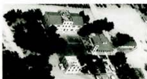
23 Στρατόπεδο «Μεγάλου Αλεξάνδρου», κτιριακό σύνολο Διοικητηρίου.
