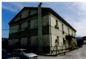
33 Στρατόπεδο «Πεδίου Άρεως», κτήριο διαμονής οπλιτών με εκτιμώμενη ανάγκη προστασίας κελύφους και εσωτερικής διαρρύθμισης.
