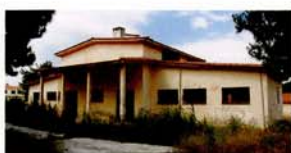
25 Στρατόπεδο «Καρατάσιου», περίκεντρο κτήριο μαγειρείων.
