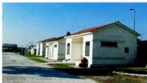
11 Στρατόπεδο «Κακιούση», κτιριακές μονάδες προς το ρέμα Δενδροποτάμου.
