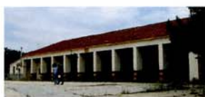
36 Στρατόπεδο «Καρατάσιου», Όρχος οχημάτων, εξωτερική άποψη.
