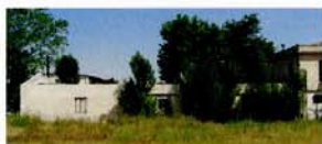
14 Στρατόπεδο «Ζιάκα», κτήριο συγκροτήματος πύλης σε κακή κατάσταση.
