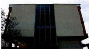
32 Στρατόπεδο «Πεδίου Άρεως», βορειοανατολικό Διοικητήριο, βόρεια όψη με υλοστάσιο στη θέση του κεντρικού διαδρόμου. Εκτιμώμενη ανάγκη προστασίας κελύφους και εσωτερικής διαρρύθμισης.
