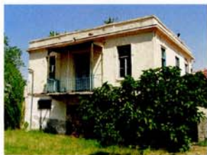
15 Στρατόπεδο «Ζιάκα», ενδιάμεσο κτήριο συγκροτήματος πύλης.
