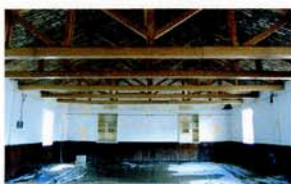
22 Στρατόπεδο «Καρατάσιου», λιθόκτιστο Κέντρο Ψυχαγωγίας Μονάδας (ΚΨΜ) με ξύλινη στέγη.
