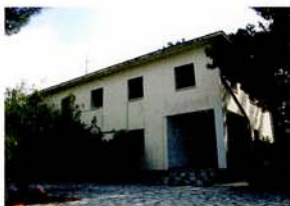
7 Στρατόπεδο «Καρατάσιου», δυτικό Διοικητήριο.
