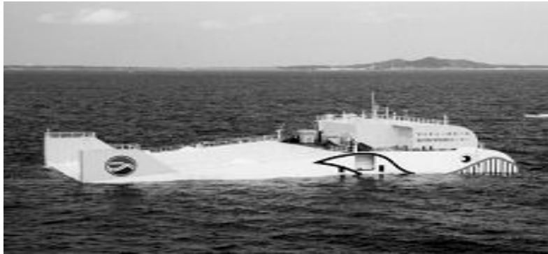
Σχήμα6. Ένα σύστημα Mighty Whale με μήκος 50 μ. και πλάτος 30 μ.
