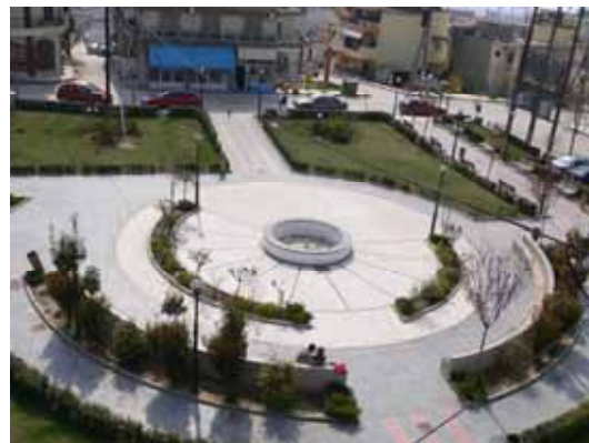
ΠΛΑΤΕΙΑ ΑΡΚΑΔΙΟΥ – ΥΠΑΡΧΟΥΣΑ ΚΑΤΑΣΤΑΣΗ
