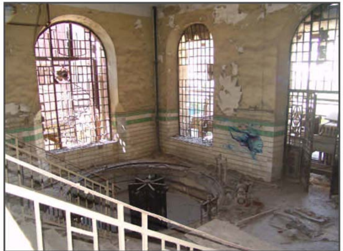
Εσωτερική άποψη του κτιρίου 2, όπου διακρίνονται οι ζυθοβραστήρες, οι χάλκινες επικαλύψεις των οποίων χάθηκαν.
