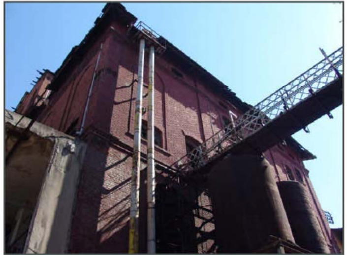
Δυτική άποψη του κτιρίου 2, όπου διακρίνεται η εξωτερική οργάνωση των όψεων.
