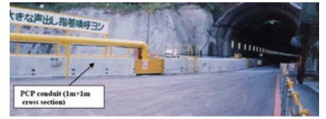
3. Εφαρμογή PCP για την κατασκευή του τούνελ Akima (Πηγή: 2)
