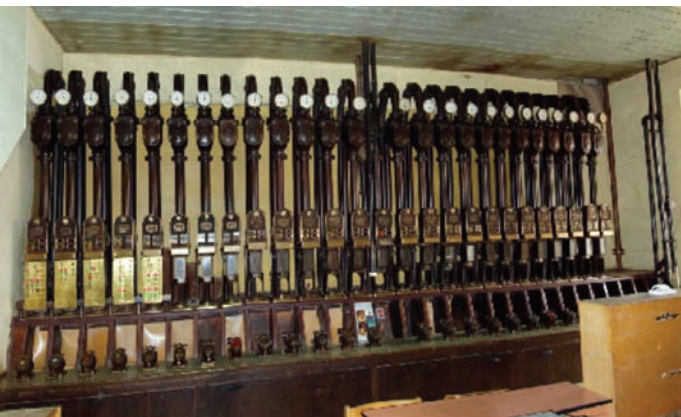
1. Παλαιού τύπου αγωγοί πνευματικής μεταφοράς στην Πράγα (Πηγή: 8)
