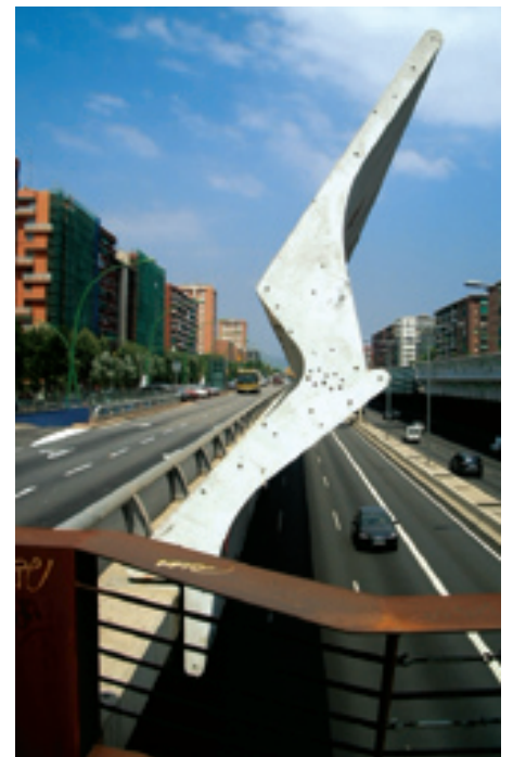
3. Κάλυψη και Αποκατάσταση της Γκραν Βία, Βαρκελώνη, Αριόλα Φιόλ, αρχιτέκτονες. /Cobriemnt Gran Via, Arriola/Fiol, arquitectes
