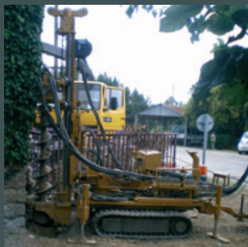
ΜΙΚΡΟΠΑΣΣΑΛΟΙ - ΥΠΟΘΕΜΕΛΙΩΣΕΙΣ
