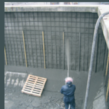
GUNITE - ΕΚΤΟΞΕΥΟΜΕΝΟ ΣΚΥΡΟΔΕΜΑ
