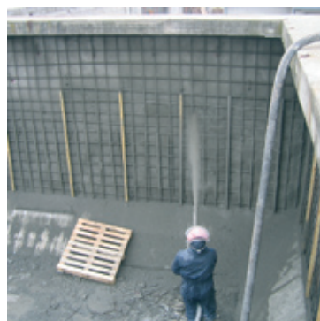
GUNITE - ΕΚΤΟΞΕΥΟΜΕΝΟ ΣΚΥΡΟΔΕΜΑ
