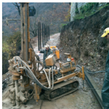
ΜΙΚΡΟΠΑΣΣΑΛΟΙ - ΥΠΟΘΕΜΕΛΙΩΣΕΙΣ
