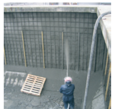
GUNITE - ΕΚΤΟΞΕΥΟΜΕΝΟ ΣΚΥΡΟΔΕΜΑ
