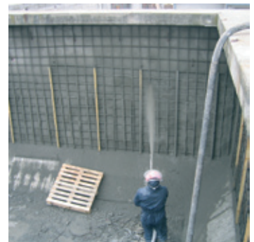
GUNITE - ΕΚΤΟΞΕΥΟΜΕΝΟ ΣΚΥΡΟΔΕΜΑ
