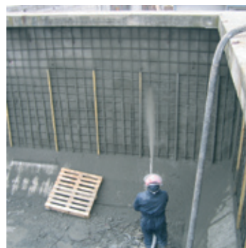
GUNITE - ΕΚΤΟΞΕΥΟΜΕΝΟ ΣΚΥΡΟΔΕΜΑ
