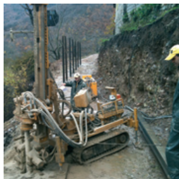
ΜΙΚΡΟΠΑΣΣΑΛΟΙ - ΥΠΟΘΕΜΕΛΙΩΣΕΙΣ
