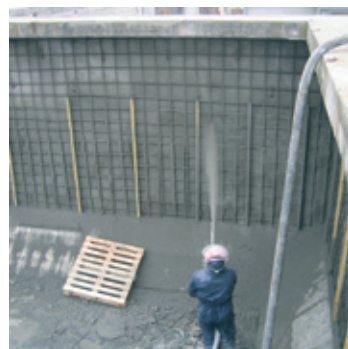
GUNITE - ΕΚΤΟΞΕΥΟΜΕΝΟ ΣΚΥΡΟΔΕΜΑ
