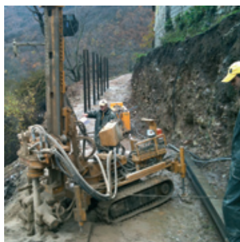
ΜΙΚΡΟΠΑΣΣΑΛΟΙ - ΥΠΟΘΕΜΕΛΙΩΣΕΙΣ
