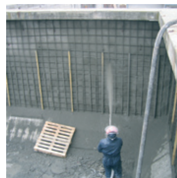
GUNITE - ΕΚΤΟΞΕΥΟΜΕΝΟ ΣΚΥΡΟΔΕΜΑ
