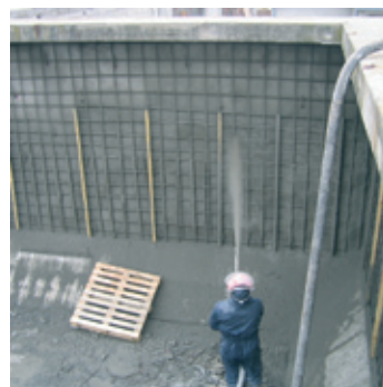
GUNITE - ΕΚΤΟΞΕΥΟΜΕΝΟ ΣΚΥΡΟΔΕΜΑ
