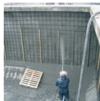
GUNITE - ΕΚΤΟΞΕΥΟΜΕΝΟ ΣΚΥΡΟΔΕΜΑ
