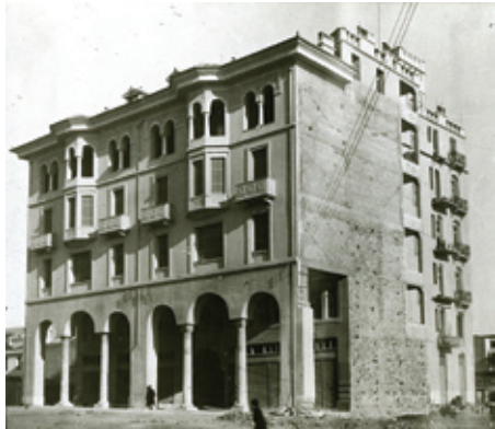
Οικοδομή στον μνημειακό άξονα της οδού Αριστοτέλους [Σαλ. Παζέλλι, 1923] Αρχείο Β. Κολώνα
