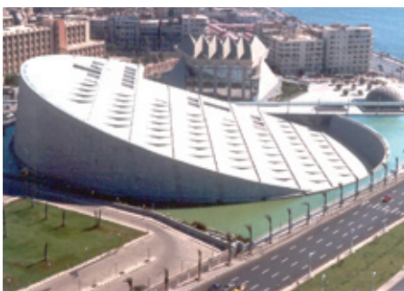
Bibliotheca Alexandrina. Ο βασικός χώρος ανάγνωσης βρίσκεται κάτω από μια οροφή ύψους 33 μέτρων -στο ψηλότερο σημείο της- φτιαγμένη από γυάλινα πάνελ, που "κλίνει" προς την πλευρά της θάλασσας, με διάμετρο 160 μέτρων. Οι τοίχοι της Βιβλιοθήκης είναι φτιαγμένοι από γκρίζο γρανίτη του Ασουάν, χαραγμένοι με χαρακτήρες από 120 διαφορετικά συγγράμματα. Πηγή φωτογραφίας: Openbuildings.com.
