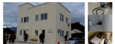
Σχήμα 2. Ενοργάνωση κτιρίου Διοίκησης του Νοσοκομείου στο Ληξούρι. Φαίνονται τα επιταχυνσιομέτρα στην κορυφή στον όροφο και στο υπόγειο. www.itsak-oasp.gr
