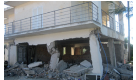
Φωτ. 4. Κτίριο στο χωριό Άγιος Δημήτριος βόρεια του Ληξουρίου, δώροφο, που κτυπήθηκε από τον πρώτο 26-1-2014 (πάνω) και δεύτερο σεισμό της 3-2-2014 (κάτω). Η επιβάρυνση από τον δεύτερο είναι ιδιαίτερα μεγάλη. www.itsak.gr
