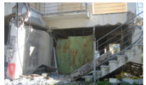
Φωτ. 3. Κτίριο στο χωριό Άγιος Δημήτριος βόρεια του Ληξουρίου, δώροφο, που κτυπήθηκε από τον πρώτο 26-1-2014 (πάνω) και δεύτερο σεισμό της 3-2-2014 (κάτω). Η επιβάρυνση από τον δεύτερο είναι πολύ μεγάλη. www.itsak.gr
