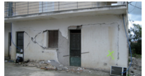
Φωτ. 3. Κτίριο στο χωριό Άγιος Δημήτριος βόρεια του Ληξουρίου, δώροφο, που κτυπήθηκε από τον πρώτο 26-1-2014 (πάνω) και δεύτερο σεισμό της 3-2-2014 (κάτω). Η επιβάρυνση από τον δεύτερο είναι πολύ μεγάλη. www.itsak.gr
