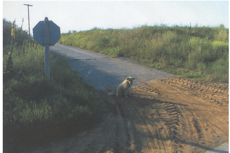
18ο χλμ Εθν. Οδού Κιλκίς - Ν. Πετριτσίου
