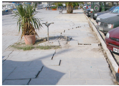
2.2 Ρηγματωμένες πλακοστρώσεις και πεζοδρομήσεις στην πόλη της Λευκάδας εξαιτίας εδαφικών καθιζήσεων και πλευρικών μετακινήσεων.
