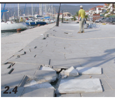
2.3 Θέση Β2. Στην περιοχή του κάστρου Λευκάδας παρατηρήθηκαν φαινόμενα ρευστοποίησης, πλευρική μετακίνησης και καθιζήσεων.
