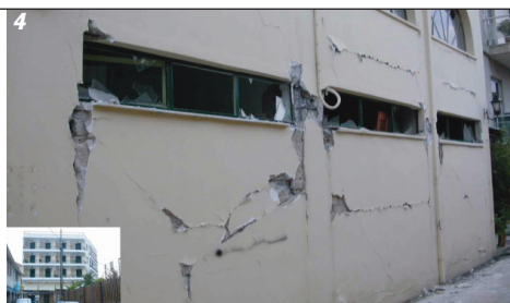
Φωτ. 1 Πτώσεις κεραμιδιών από τις στέγες Φωτ. 2 Παραδοσιακό κτίριο με διπλό δομικό σύστημα Φωτ. 3 Το κτίριο (τριώροφο+σοφίτα) της οδού Ζαμπέλη που κατέρρευσε Φωτ. 4 Τετραώροφο κτίριο με βλάβες στο κέντρο της Λευκάδας θεμελιωμένο σε πασσάλους Φωτ. 5 Αστοχίες & αποκατάσταση μεταλλικών αγωγών λόγω διαφορικής καθίζησης κτιρίων επί της οδού Γκολέμη Φωτ. 6 Διώροφο κτίριο ύψους 7m Φωτ. 7 Διατμητική αστοχία σε υποστυλώμα Φωτ. 8 Διατμητική αστοχία κοντού υποστυλώματος
