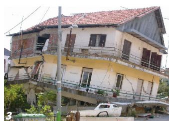
Φωτ. 1 Πτώσεις κεραμιδιών από τις στέγες Φωτ. 2 Παραδοσιακό κτίριο με διπλό δομικό σύστημα Φωτ. 3 Το κτίριο (τριώροφο+σοφίτα) της οδού Ζαμπέλη που κατέρρευσε Φωτ. 4 Τετραώροφο κτίριο με βλάβες στο κέντρο της Λευκάδας θεμελιωμένο σε πασσάλους Φωτ. 5 Αστοχίες & αποκατάσταση μεταλλικών αγωγών λόγω διαφορικής καθίζησης κτιρίων επί της οδού Γκολέμη Φωτ. 6 Διώροφο κτίριο ύψους 7m Φωτ. 7 Διατμητική αστοχία σε υποστυλώμα Φωτ. 8 Διατμητική αστοχία κοντού υποστυλώματος
