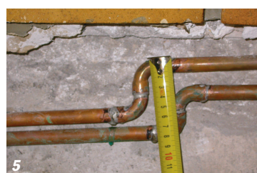
Φωτ. 1 Πτώσεις κεραμιδιών από τις στέγες Φωτ. 2 Παραδοσιακό κτίριο με διπλό δομικό σύστημα Φωτ. 3 Το κτίριο (τριώροφο+σοφίτα) της οδού Ζαμπέλη που κατέρρευσε Φωτ. 4 Τετραώροφο κτίριο με βλάβες στο κέντρο της Λευκάδας θεμελιωμένο σε πασσάλους Φωτ. 5 Αστοχίες & αποκατάσταση μεταλλικών αγωγών λόγω διαφορικής καθίζησης κτιρίων επί της οδού Γκολέμη Φωτ. 6 Διώροφο κτίριο ύψους 7m Φωτ. 7 Διατμητική αστοχία σε υποστυλώμα Φωτ. 8 Διατμητική αστοχία κοντού υποστυλώματος
