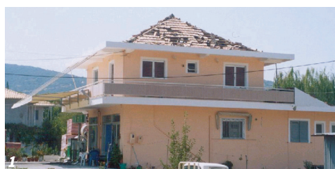
Φωτ. 1 Πτώσεις κεραμιδιών από τις στέγες Φωτ. 2 Παραδοσιακό κτίριο με διπλό δομικό σύστημα Φωτ. 3 Το κτίριο (τριώροφο+σοφίτα) της οδού Ζαμπέλη που κατέρρευσε Φωτ. 4 Τετραώροφο κτίριο με βλάβες στο κέντρο της Λευκάδας θεμελιωμένο σε πασσάλους Φωτ. 5 Αστοχίες & αποκατάσταση μεταλλικών αγωγών λόγω διαφορικής καθίζησης κτιρίων επί της οδού Γκολέμη Φωτ. 6 Διώροφο κτίριο ύψους 7m Φωτ. 7 Διατμητική αστοχία σε υποστυλώμα Φωτ. 8 Διατμητική αστοχία κοντού υποστυλώματος
