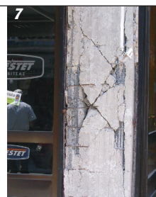
Φωτ. 1 Πτώσεις κεραμιδιών από τις στέγες Φωτ. 2 Παραδοσιακό κτίριο με διπλό δομικό σύστημα Φωτ. 3 Το κτίριο (τριώροφο+σοφίτα) της οδού Ζαμπέλη που κατέρρευσε Φωτ. 4 Τετραώροφο κτίριο με βλάβες στο κέντρο της Λευκάδας θεμελιωμένο σε πασσάλους Φωτ. 5 Αστοχίες & αποκατάσταση μεταλλικών αγωγών λόγω διαφορικής καθίζησης κτιρίων επί της οδού Γκολέμη Φωτ. 6 Διώροφο κτίριο ύψους 7m Φωτ. 7 Διατμητική αστοχία σε υποστυλώμα Φωτ. 8 Διατμητική αστοχία κοντού υποστυλώματος
