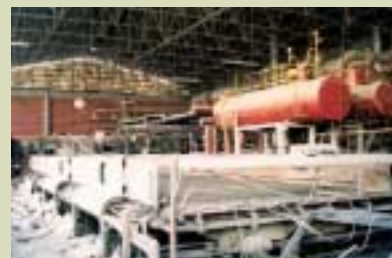
Άποψη από το εσωτερικό του κτιρίου.
