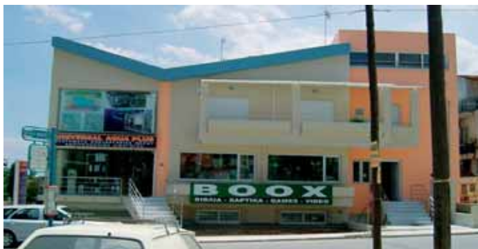
Έξυπνο Κτίριο KNX/EIB Γεωργιάδη στο Γέρακα Αττικής.
