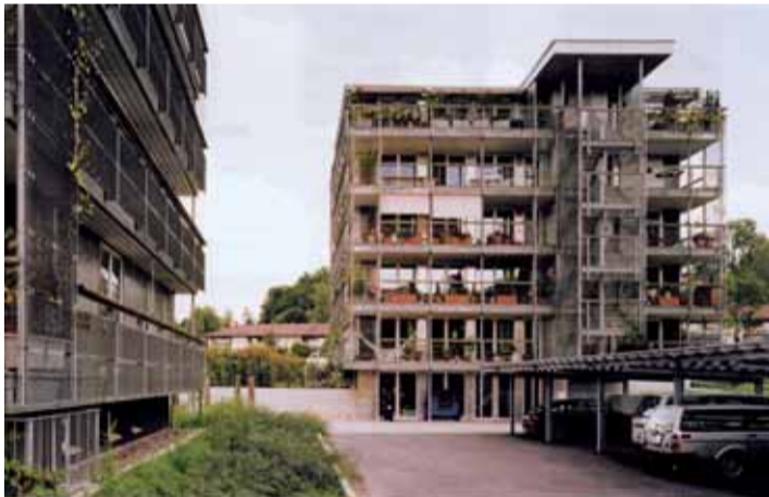
Ανάπτυξη πρασίνου σε όψεις κτιρίων
