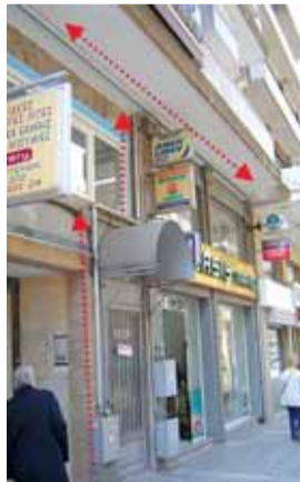
Οδός Μπτροπόλεως. Σωλήνες τροφοδοσίας ανεβαίνουν μέχρι να καταλήξουν σε επιτοίχιους λέβητες, που συνήθως τοποθετούνται σε εξώστες.
