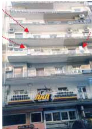
Οδός Μπτροπόλεως. Σωλήνες τροφοδοσίας ανεβαίνουν μέχρι να καταλήξουν σε επιτοίχιους λέβητες, που συνήθως τοποθετούνται σε εξώστες.
