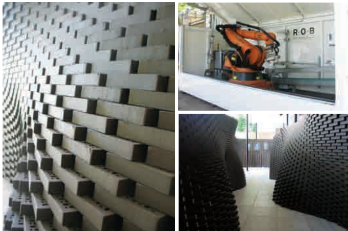
Studio, Gramazio & Kohler Architecture and Digital Fabrication ETH Zurich Ρομποτική κατασκευή σε πραγματική κλίμακα
