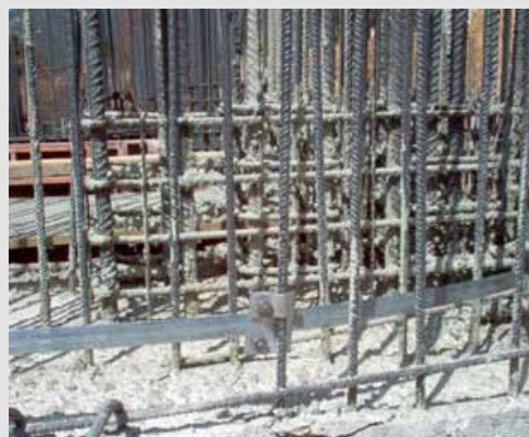
Σχήμα 1.6.3 Φωτογραφίες από την τοποθέτηση και τη σύνδεση ηλεκτροδίου θεμελιακής γείωσης από χαλύβδινη θερμά γαλβανισμένη ταινία. Φαίνονται και οι συνδέσεις με τον οπλισμό του σκυροδέματος.
