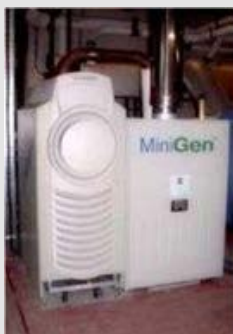
Σχήμα 3.1.4. Σύστημα μικρο-τριπαραγωγής με στρόβιλο
