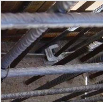
Σχήμα 1.6.3 Φωτογραφίες από την τοποθέτηση και τη σύνδεση ηλεκτροδίου θεμελιακής γείωσης από χαλύβδινη θερμά γαλβανισμένη ταινία. Φαίνονται και οι συνδέσεις με τον οπλισμό του σκυροδέματος.
