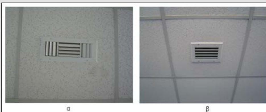
Σχήμα 2.2.13. (α) Στόμιο κλιματισμού προσαγωγής νωπού αέρα τριών (3) κατευθύνσεων, (β) Στόμιο εξαερισμού μιας (1) κατεύθυνσης
