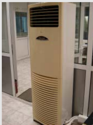
Σχήμα 2.2.19: Εσωτερικό τμήμα, ισταμένου τύπου (νουλάπας)
