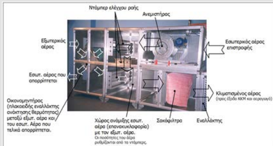
Σχήμα 1.1.8. Κεντρική κλιματιστική μονάδα
