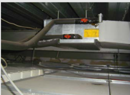
Σχήμα 2.2.7. Fan Coil Ισογείου
