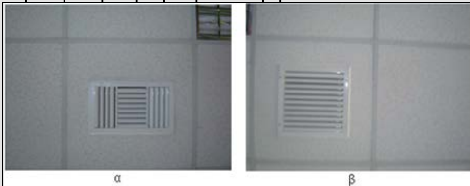
Σχήμα 2.2.12. (α) Στόμιο κλιματισμού (Προσαγωγής) τριών (3) κατευθύνσεων (β) Στόμιο κλιματισμού (επιστροφής) μιας (1) κατεύθυνσης
