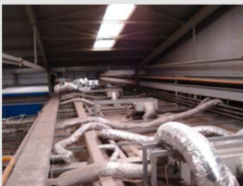
Σχήμα 2.2.11. Δίκτυα Αεραγωγών Νωπού και Αέρα Απόρριψης
