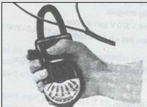
Σχήμα 1.5.5. Μέτρηση της έντασης με αμπεροτσιμπίδα, σε μονοφασική γραμμή μονάδας κλιματισμού.
