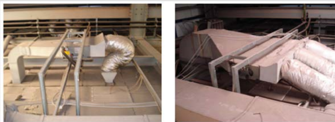
Σχήμα 2.2.6. Fan Coils Ορόφου
